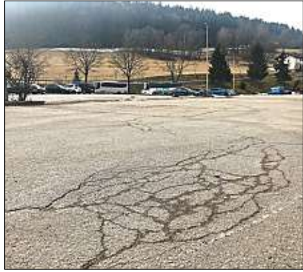
Der marode Asphalt am Freibadparkplatz wird erneuert. – Foto: Jahns
